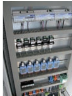
Datenloggerschrank von EnWi-Etec
