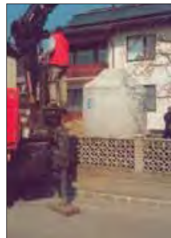
Bild: Versetzen der GEP-Regenwasserzisterne im Vorgarten von Ökohaushaus
