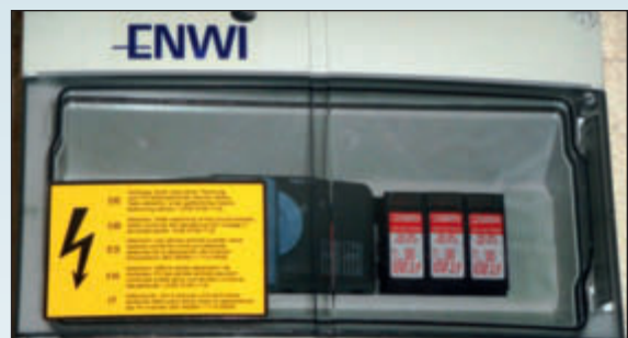
Bild Ökohaus-Althaus Generatoranschlusskasten von EnWi-Etec
