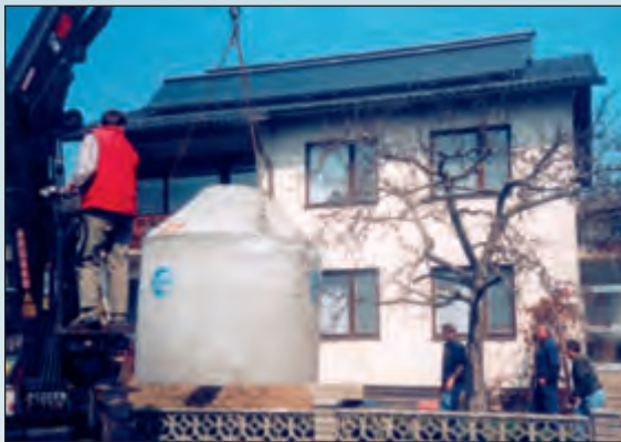
Bild Versetzen der GEP-Regenwasserzisterne im Vorgarten von Ökohaus-Althaus
