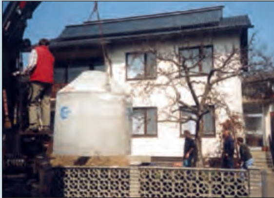
Bild: Versetzen der GEP-Regenwasserzisterne im Vorgarten von Ökohaus-Althaus
