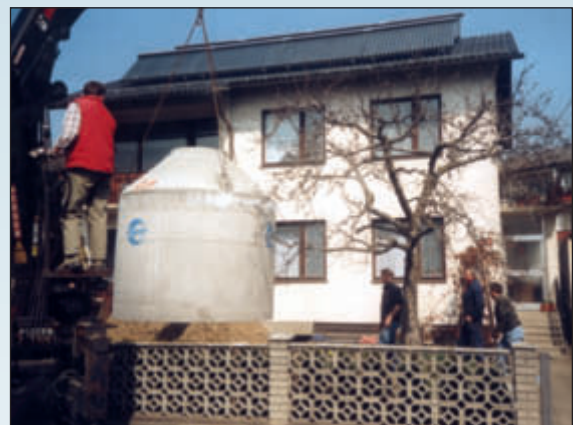
Bild Versetzen der GEP-Regenwasserzisterne im Vorgarten von Ökohaus-Althaus
