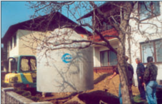
Bild Versetzen der GEP-Regenwasserzisterne im Vorgarten von Ökohaus-Althaus
