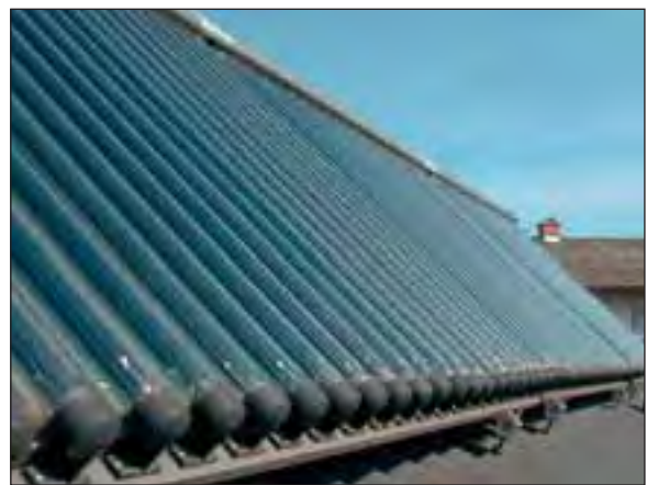
Bild: SOLution VAKUSOL am Dach von Ökohaushaus-Althaus.
