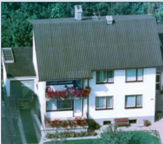
Bild Ökohaushaus-Althaus vor der Sanierung
