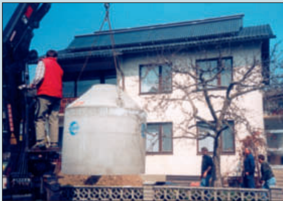
Bild Versetzen der GEP-Regenwasserzisterne im Vorgarten von Ökohaus-Althaus
