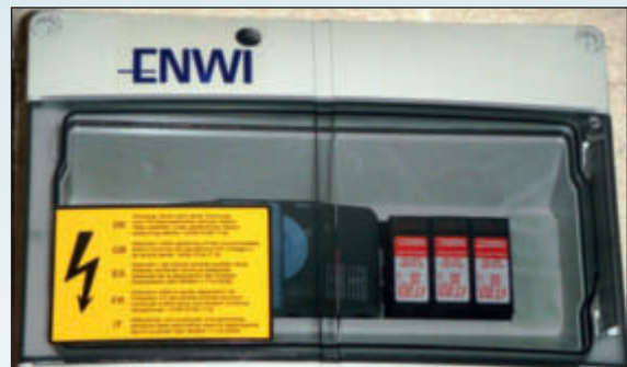
Bild Ökohaus-Althaus Generatoranschlusskasten von EnWi-Etec
