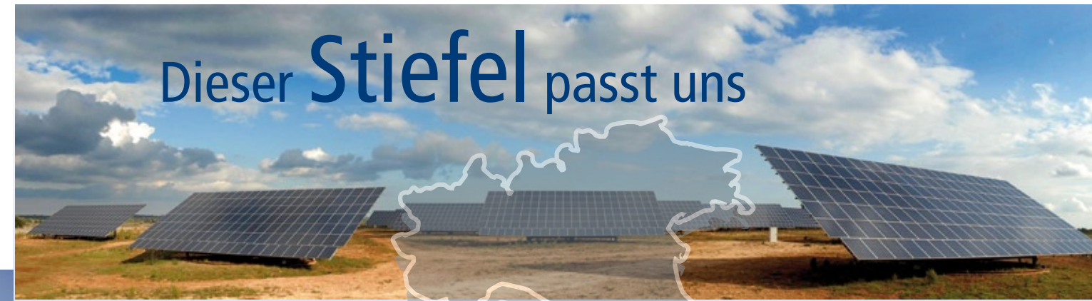
Bella macchina in San Cassiano: 1 MW bringt sich in Stellung.
