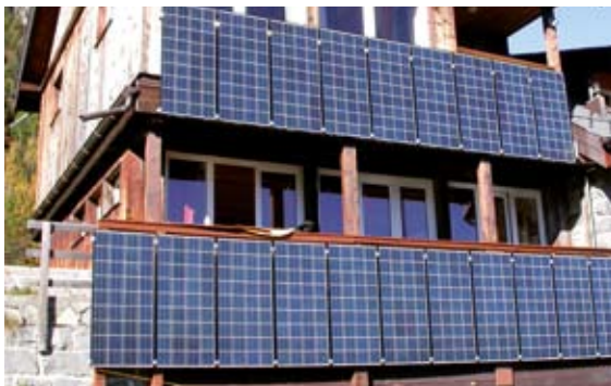
Gewinner-Installation der stromaufwärts Photovoltaik GmbH
