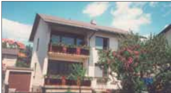
Bild Ökohaus-Althaus vor der Sanierung
