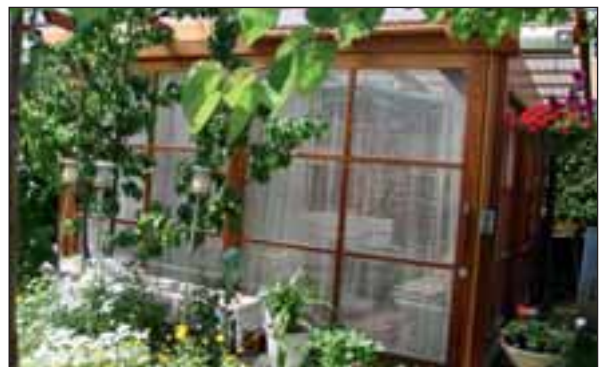
Gartenidylle nach Sanierung von ÖkoHaus-Althaus
