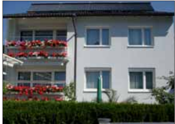
ÖkoHaus-Althaus nach der Sanierung
