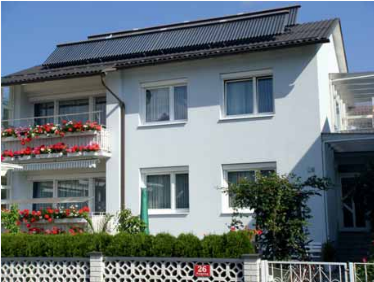
Bild: © Ökohaus-Althaus. Nicht nur für Neubauten, sondern auch bei der Althausanierung ist die solare Warmwasserbereitung sowie teilsolare Raumheizung optimal.
