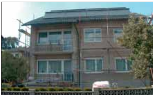
Wärmedämmte Fassade von ÖkoHaus-Althaus mit Tektalan E-21
