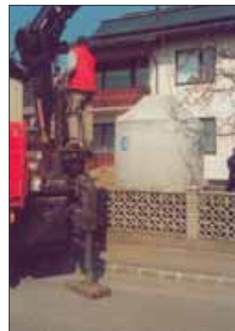
Bild: Versetzen der GEP-Regenwasserzisterne im Vorgarten von ÖkoHaus-Althaus
