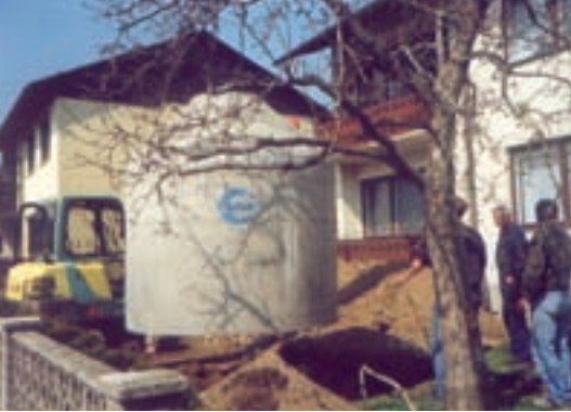
Versetzen der Zisterne
