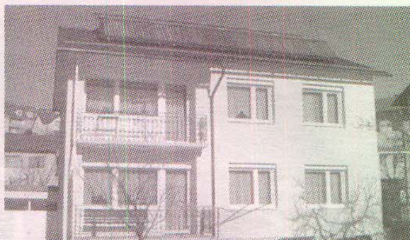
Heute ein Niedrigenergiehaus - nach Fenstertausch, Wärmedämmung und Solarintegration.
