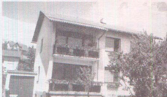
Im April 1998 entstand dieses Foto vor der Montage der Sonnenkollektoren.
