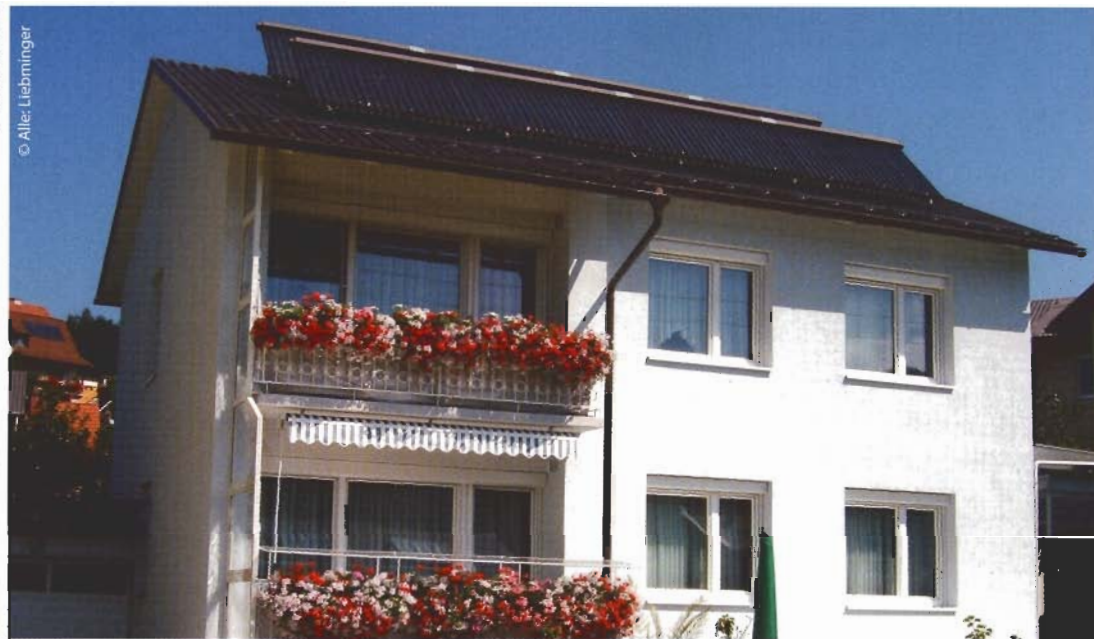
Die 30 m 2 Kollektorfläche sorgen für einen hohen solaren Deckungsanteil beim Warmwasser und bei der Heizung
